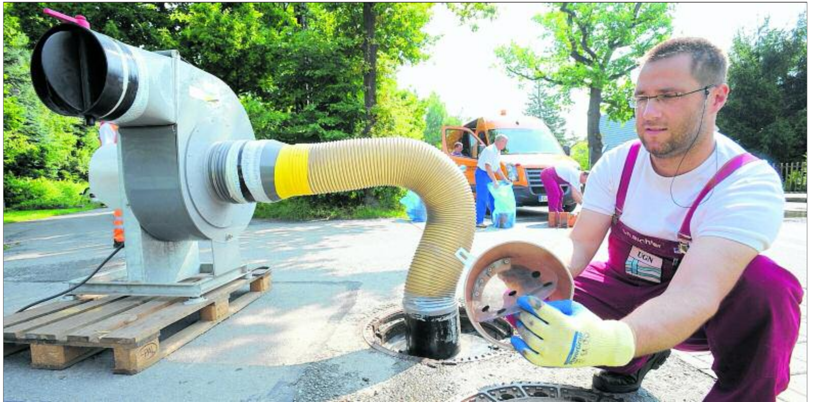
Christian Richter von der Firma UGN-Umwelttechnik aus Gera gestern beim Luftabsaugen aus einem Abwasserkanalschacht am Abzweig Schmidt-Rottluff-/Slevogtstraße in Glösa. In den Händen hält er eine Konvektions-Sperre zum Regeln des Luftstroms in Hausanschlüssen. –FOTO: ANDREAS SEIDEL
