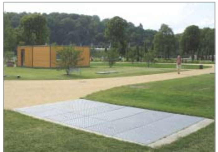
Abwasserkanalabdeckungen auf dem Gelände des Buga-Hofwiesenparks in Gera: Passende Konzepte zur Geruchsminimierung und zum Schadstoffabbau. Fotos (6): UGN-ARCHIV
