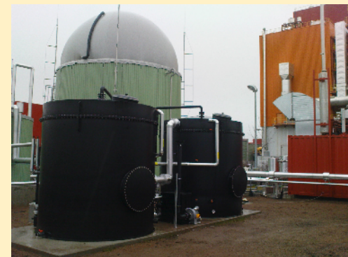
BEKOM-Anlage 120 Nm 3 /h Rohgas
