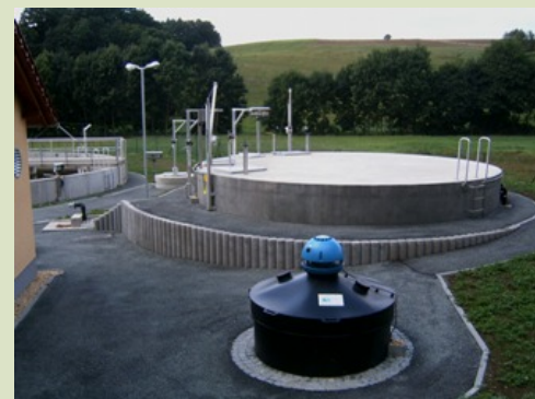
BEGA-System für Absaugung eines Schlammstapelbehälters und Rechengeringes
